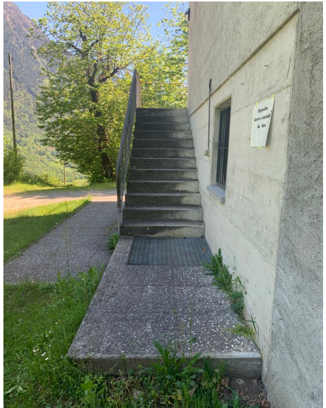
Foto 2: accesso al 1° Piano
